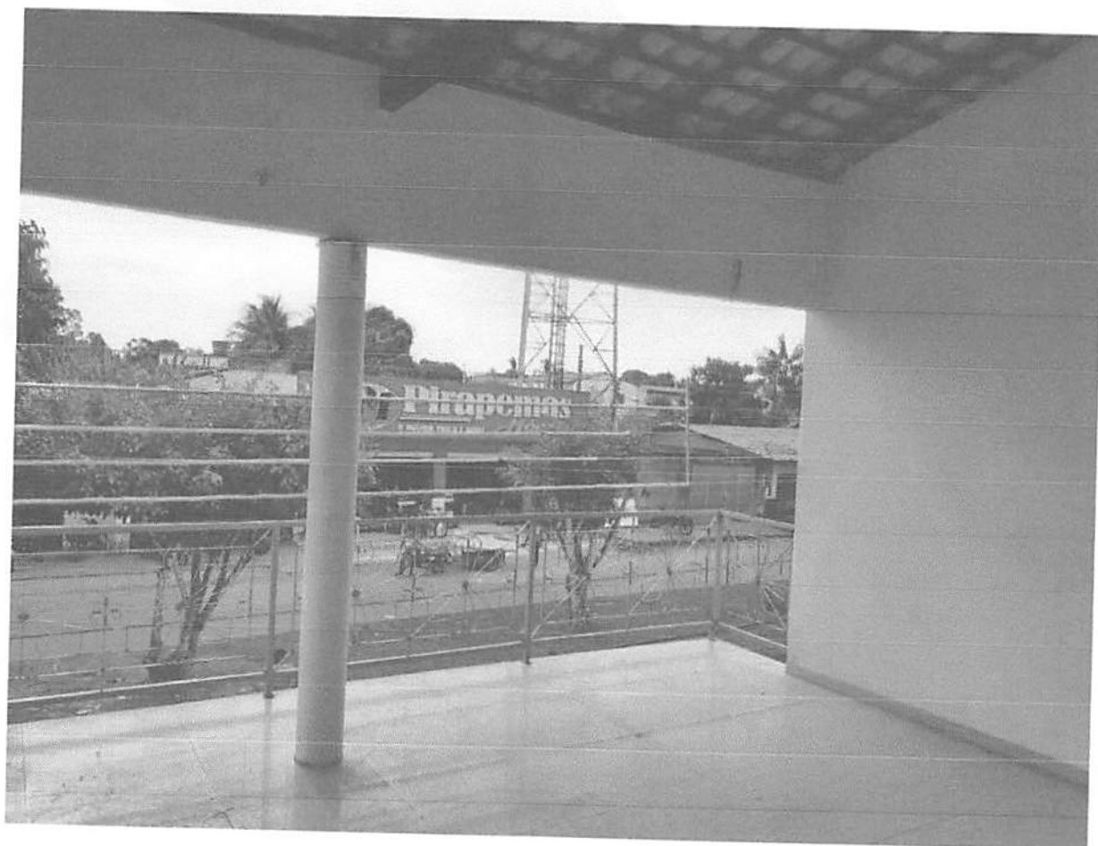
Fotografia 4 – Pav. Superior - Varanda/ Terraço
