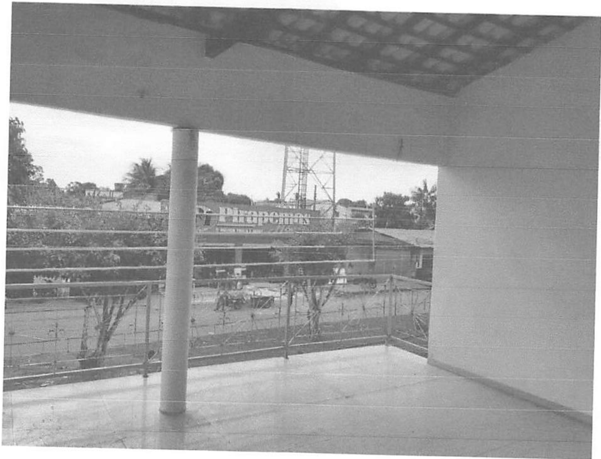
Fotografia 4 – Pav. Superior - Varanda/ Terraço
