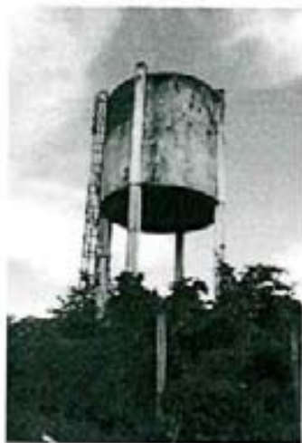
Figura 7: Poço da Rua José Rego.
