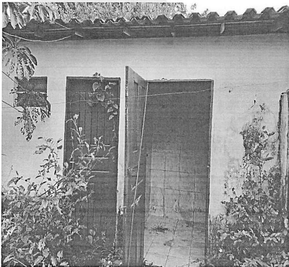
Fotografia 6- Banheiro e Depósito externos
