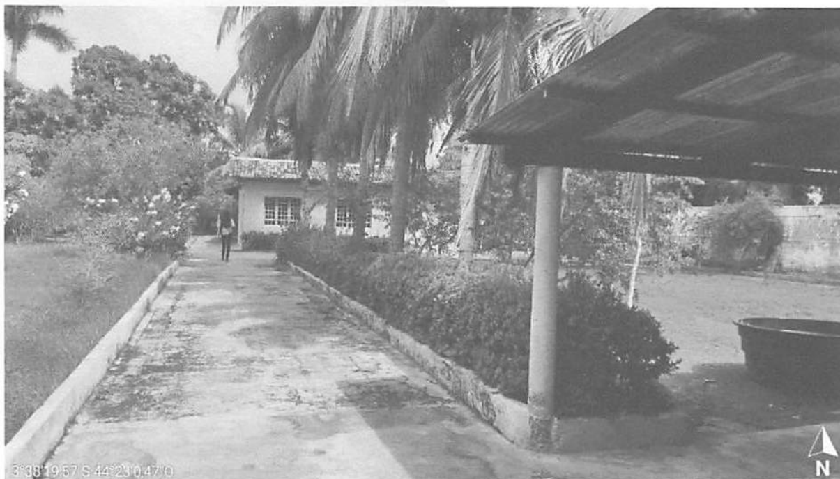
2. Passarela de acesso
