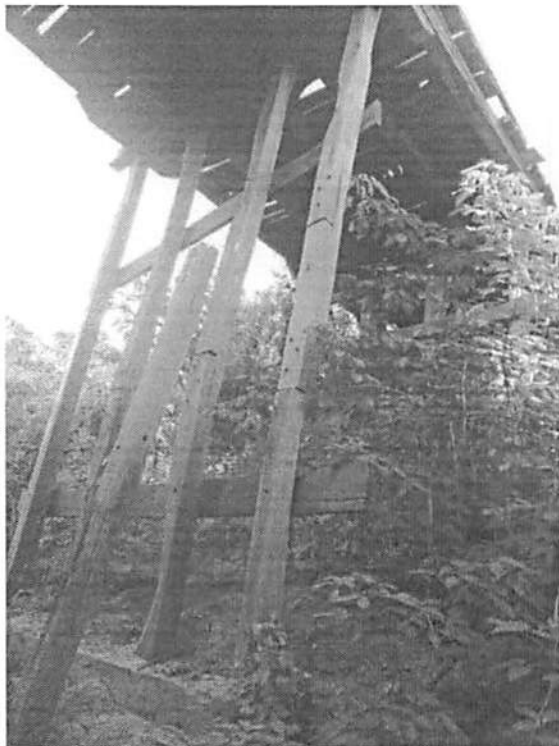
Figura 3: Pilares atuais da ponte de madeira existente
