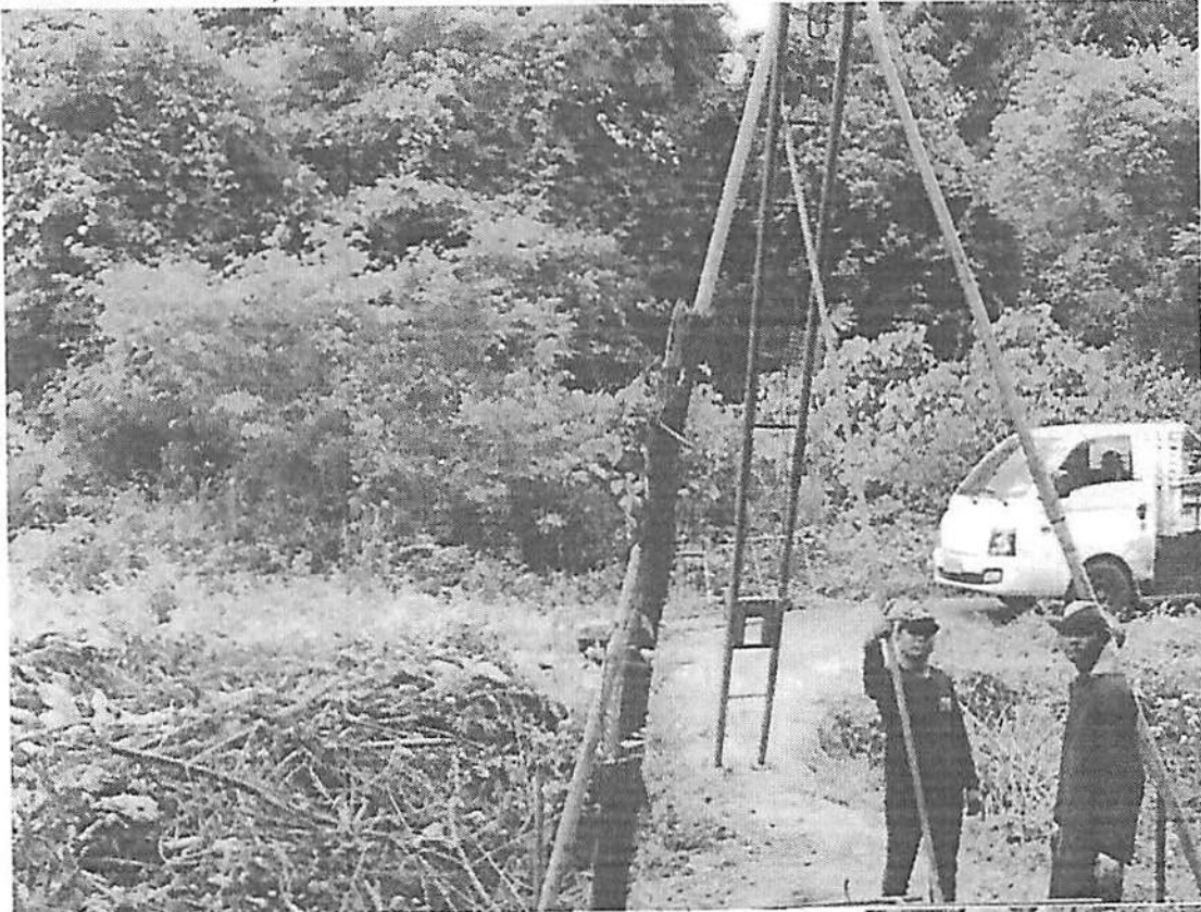
FURO 01 E FURO 02, LOCALIZADO NO POVOADO CANDIBA, PONTE DE MADEIRA
