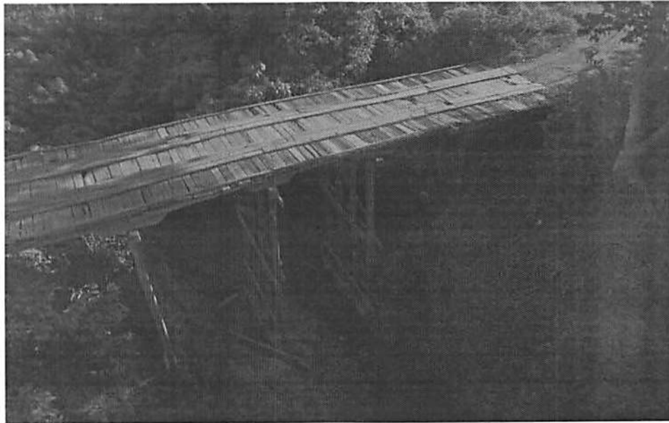
Figura 1: Ponte de madeira existente e provisória
