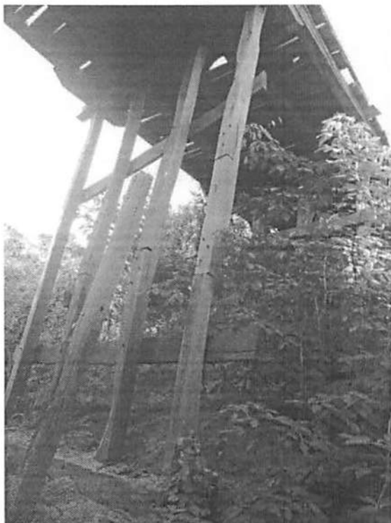
Figura 3: Pilares atuais da ponte de madeira existente
