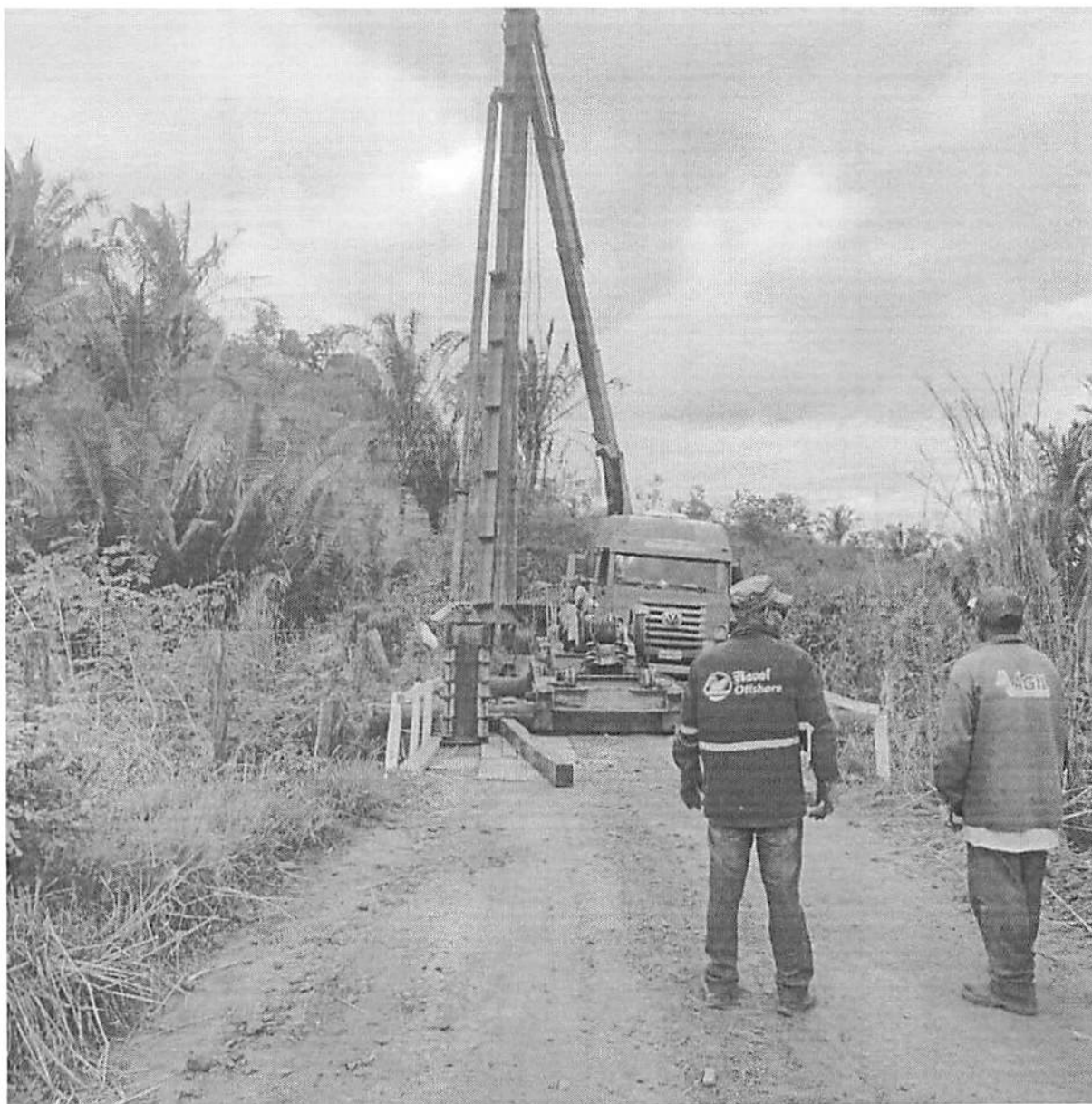
Figura 6: Bate-estaca em cima da ponte antiga, para cravar as estacas.
