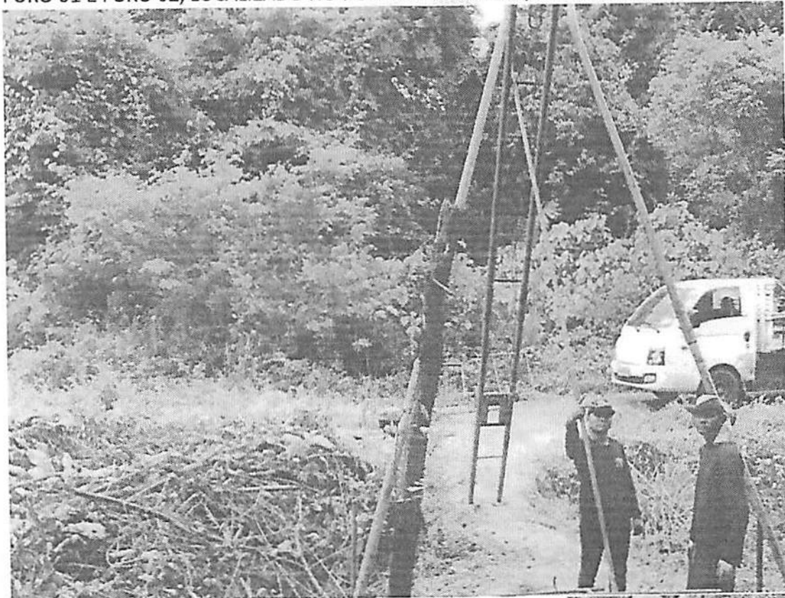
FURO 01 E FURO 02, LOCALIZADO NO POVOADO CANDIBA, PONTE DE MADEIRA
