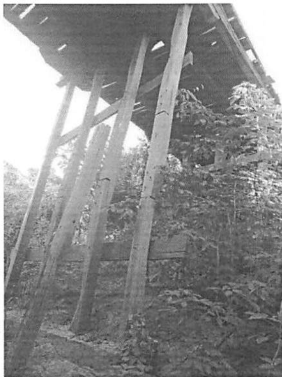
Figura 3: Pilares atuais da ponte de madeira existente
