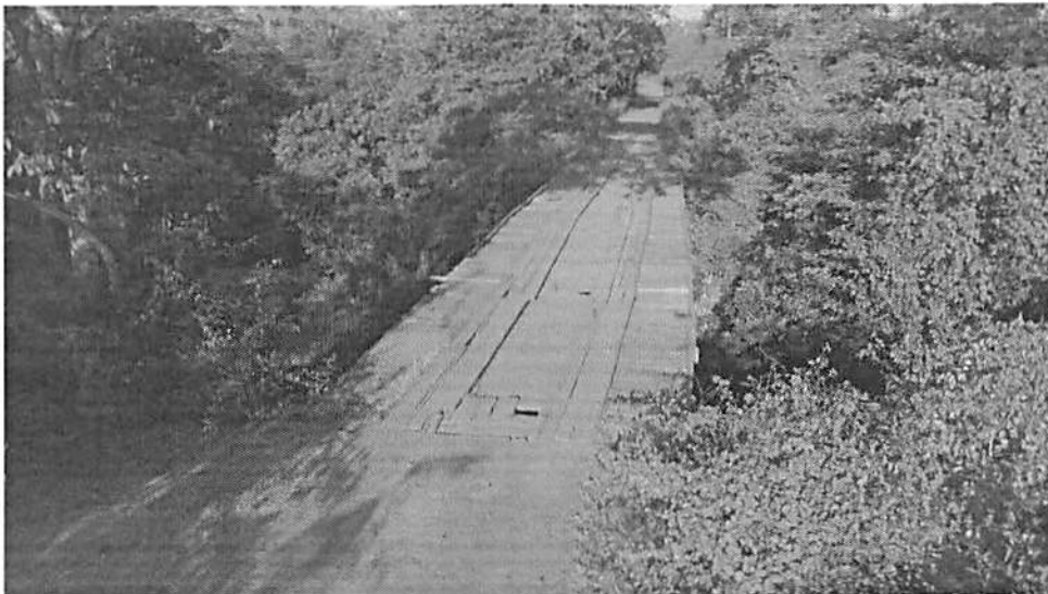
Figura 2: Ponte de madeira visto de cima
