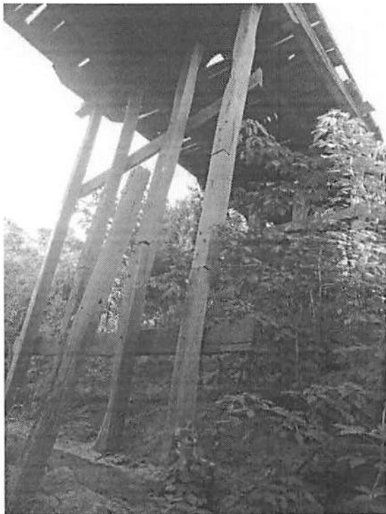
Figura 3: Pilares atuais da ponte de madeira existente
