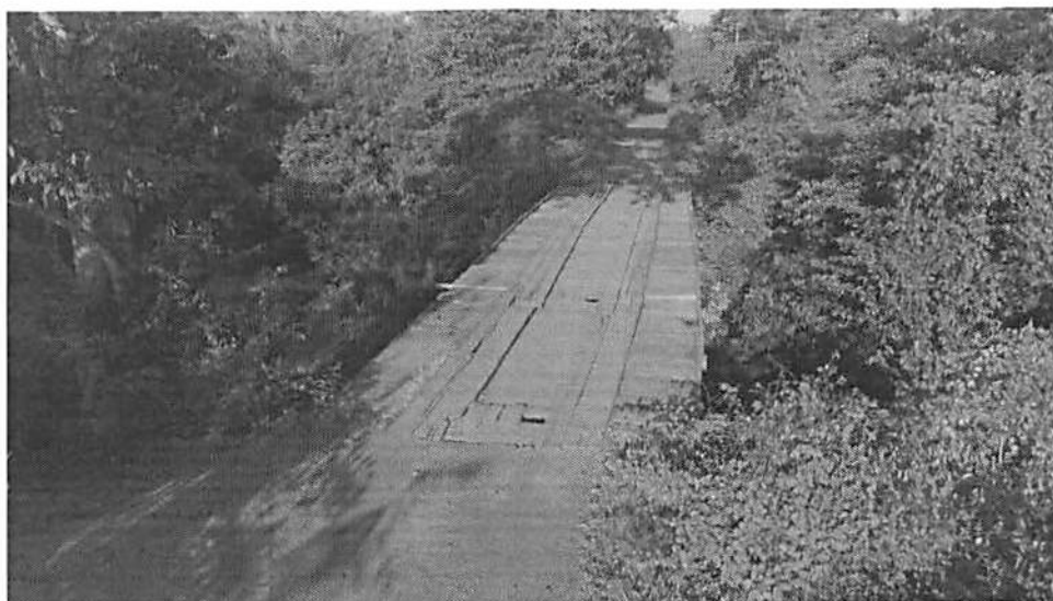
Figura 2: Ponte de madeira visto de cima
