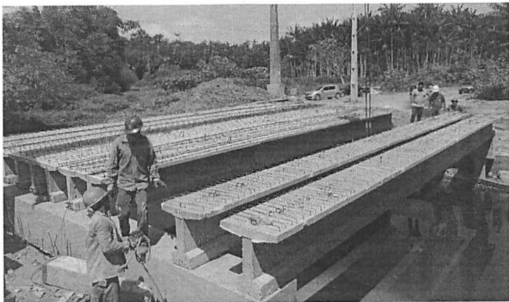
Figura 8: Vigas Protendidas apoiadas na cabeceira da ponte sem a necessidade de escoras.
